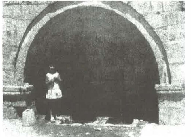
Sipas Camii Çeşmesi. (Yıkılmadan önce)
