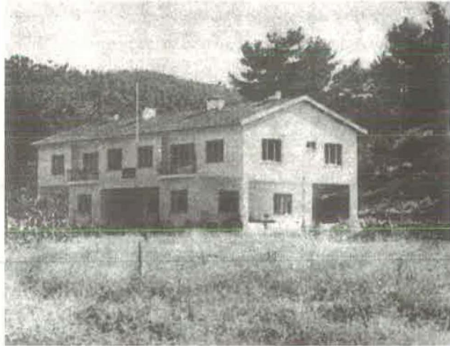
Serper'de Devlet Fidanlığı idare binası.
