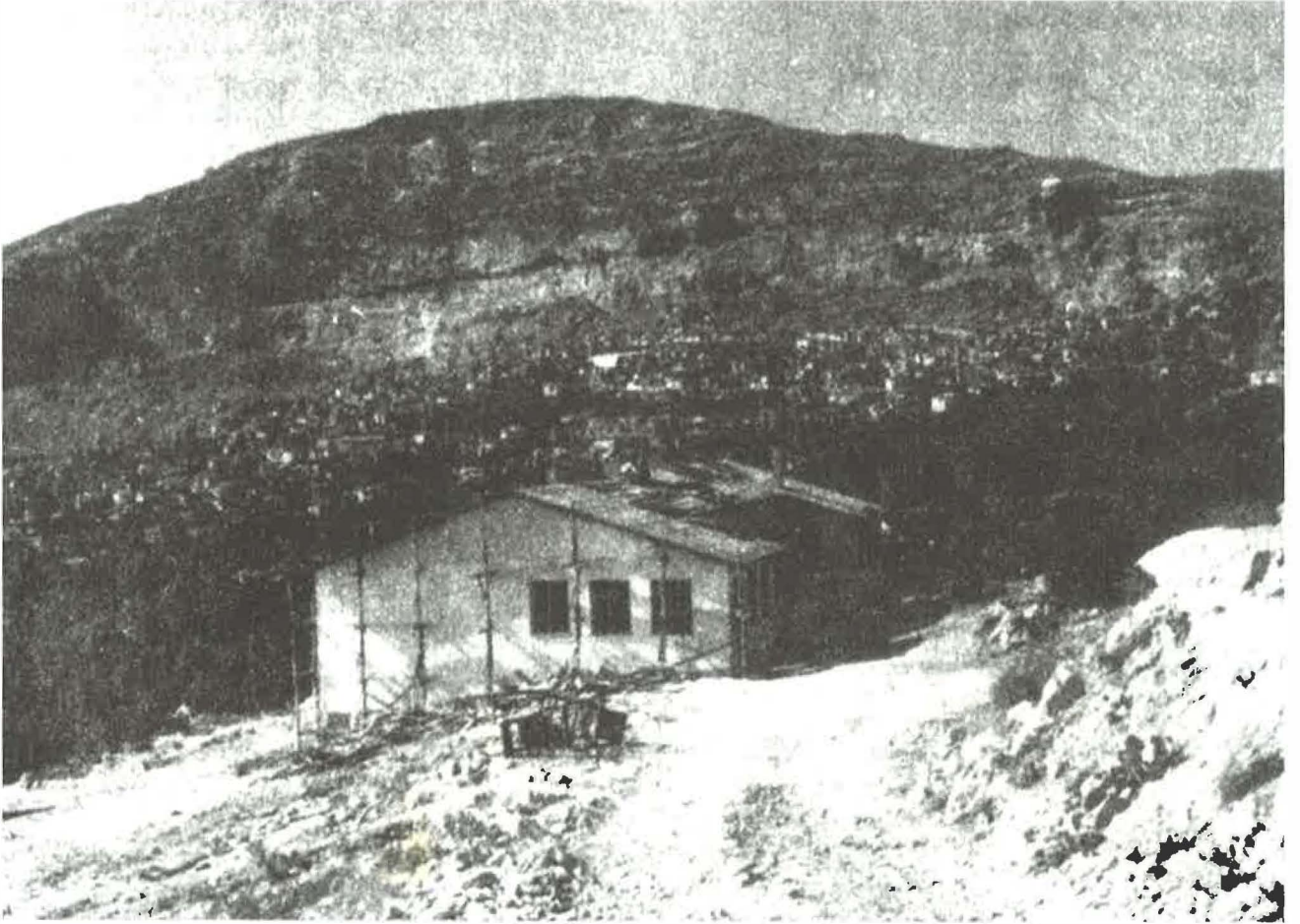
Ermenek Merkez de Seyrankaya mevkiinde yeni yapılmakta olan ilkokul binası. (1975)
