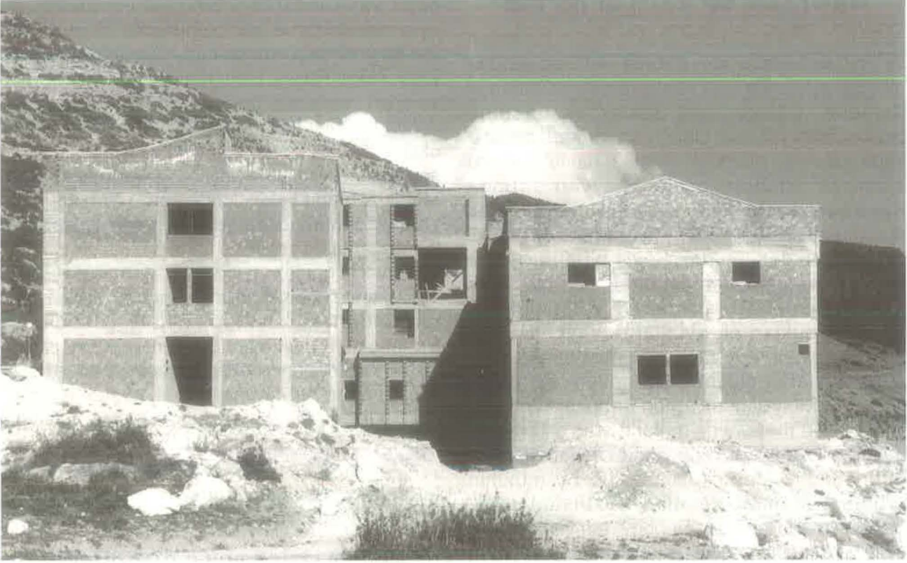
Yeni Devlet Hastanesi İnşaatı-2004 (Seyran - Fincantepesi.)
