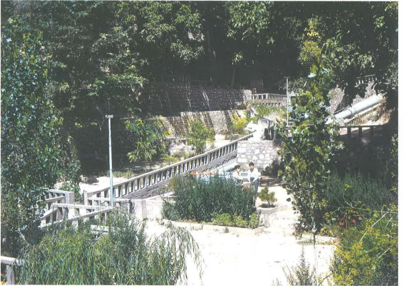
Elektrik Santralı Parkı.
