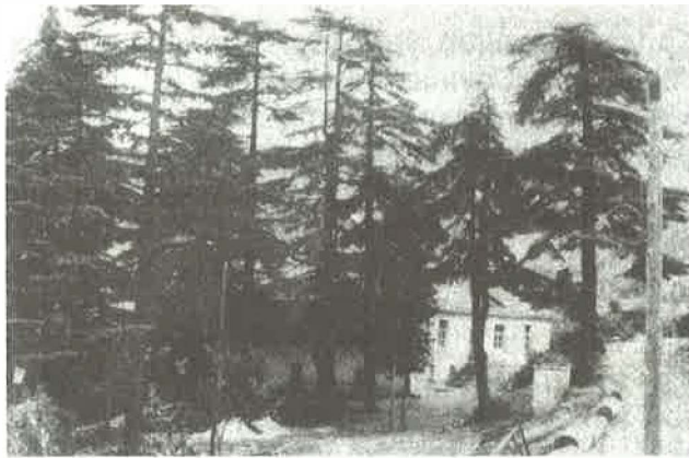
Göktepe (Fariske) bucak merkezi binası.
