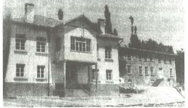
Göktepe (Fariske) İlkokulu ve Ortaokul binası.
