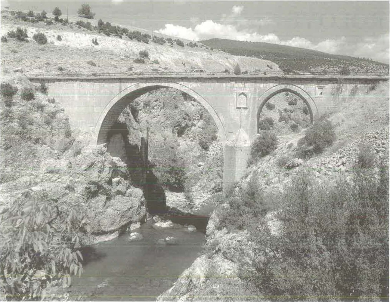
Görmel Köprüsü (Ala Köprü) 'nün batıdan görünüşü.
