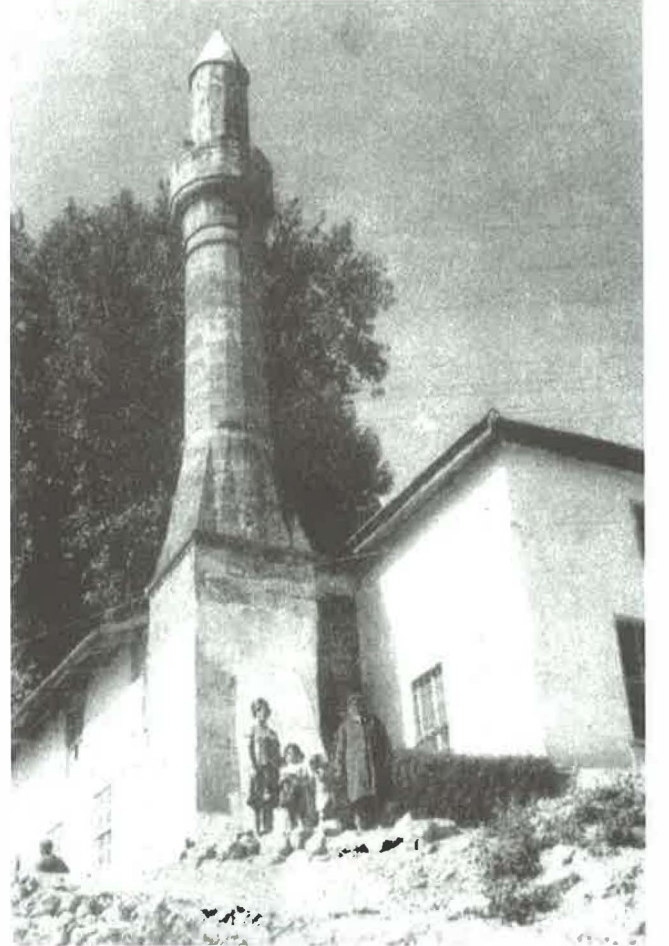
Sipas Camisi Güneybatıdan görünüş. (Restorasyondan önceki haliyle)
