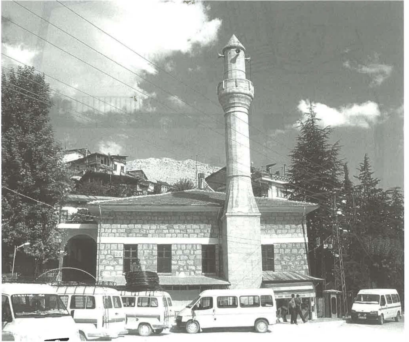
Sipas Camisi'nin batıdan görünüşü. (Restorasyondan sonraki durumu)
